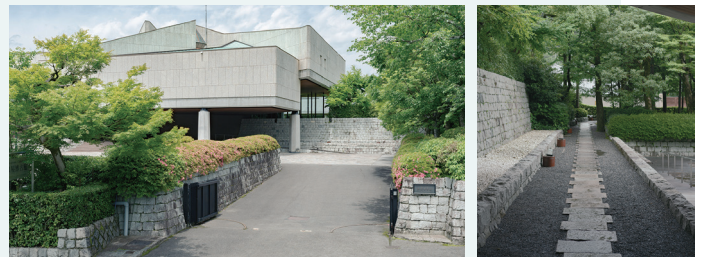
左：(改修前)1号館が見える正門。改修後は車も歩行者も入りやすく 右：(改修前)改修後は段差をなくし、車いすも通れるプロムナードに
